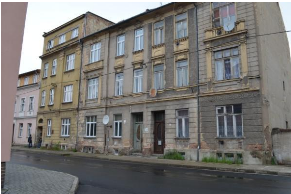
Foto 10: Dům U Požárníků 64/61 je druhý vchod zprava
